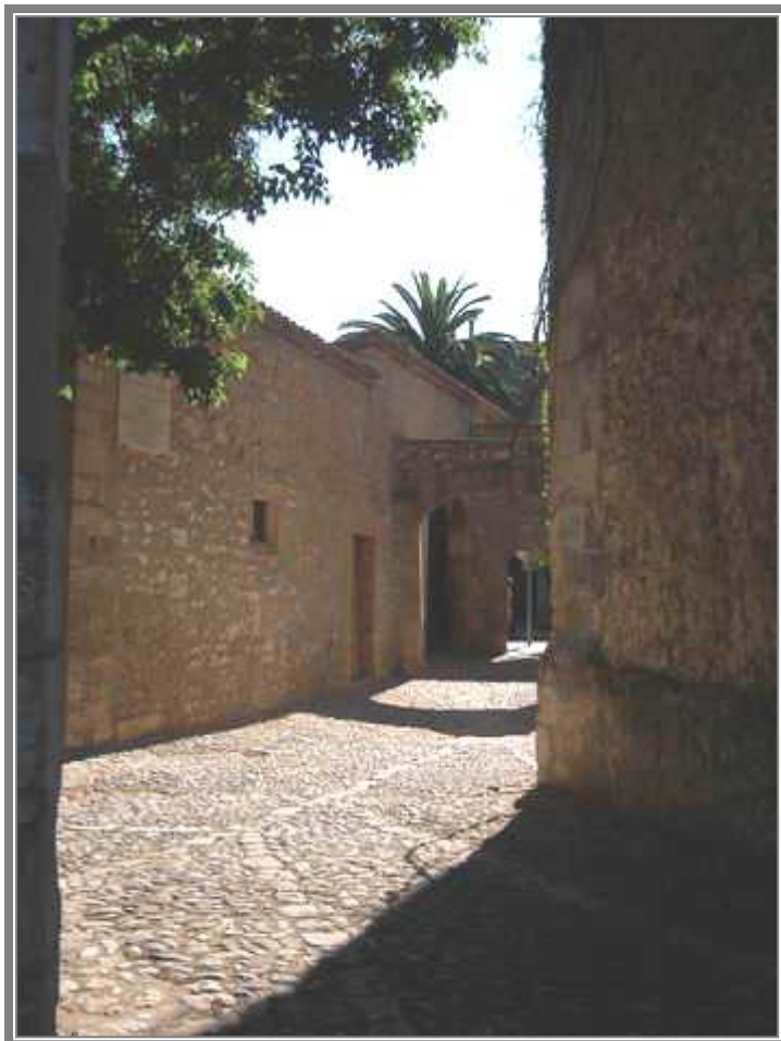
Jardins Joan March, detalle de los restos de la antigua construcción.
