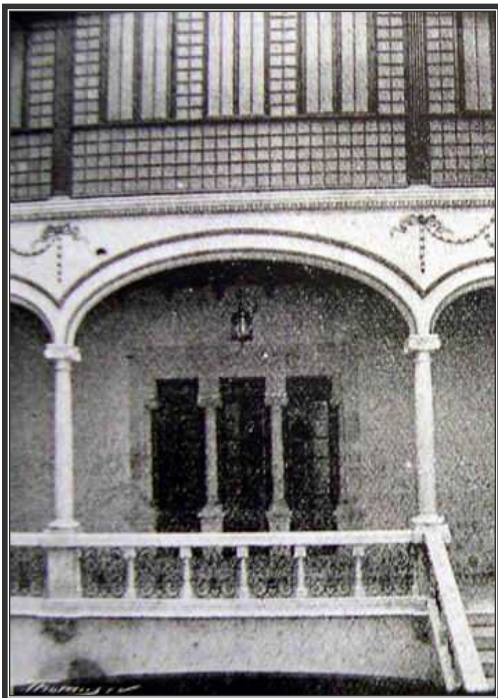
Galería de entrada, construida con mármoles de Carrara y piedra de porreras. (Revista Baleares)
