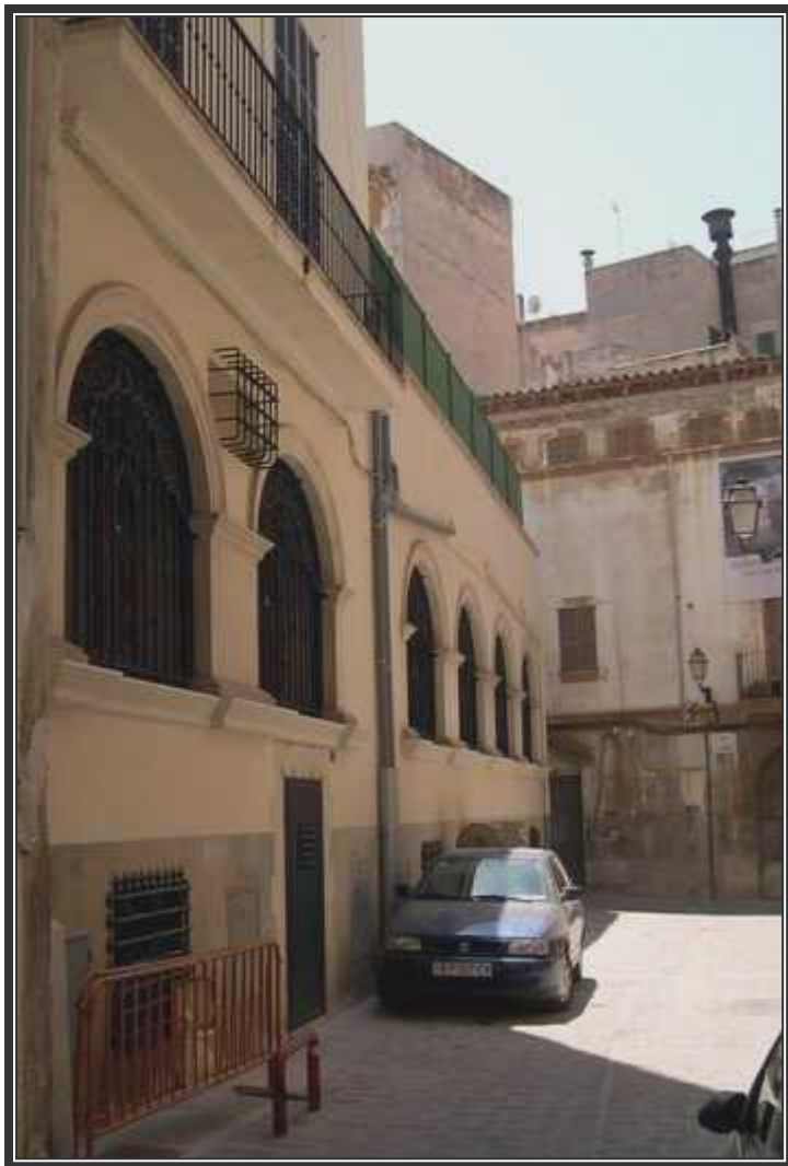
Vista de la parte trasera de la Banca March de la calle San Miguel, tal y como quedó después de la remodelación efectuada por Guillermo Forteza en 1926. (Colección Can Verga)
